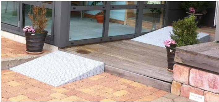
Ramper med Type I og 14,5% hældning.
